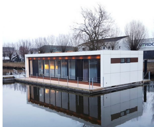
Eksisterende flydende lodsstation ved Randers Havn
