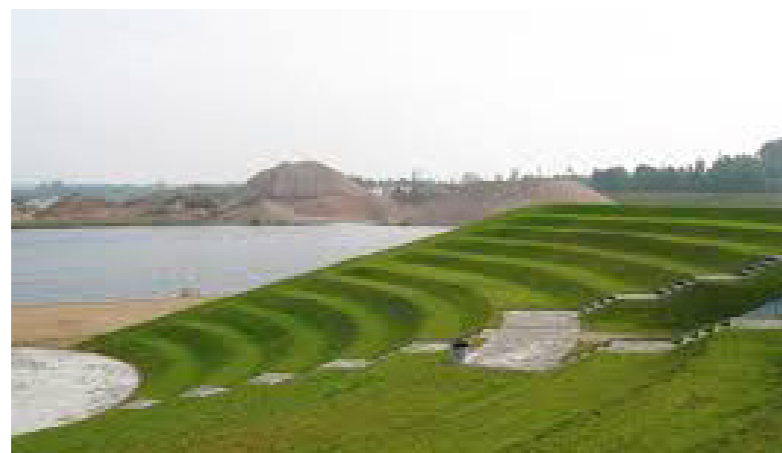
Klimatilpasning_Dige_Bagkanten af Amfien er digeopbygning
