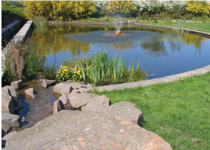
Figur 4: Opstuvning af regnvand i bassin, Augustenborg, Malmø. Foto Orbicon
