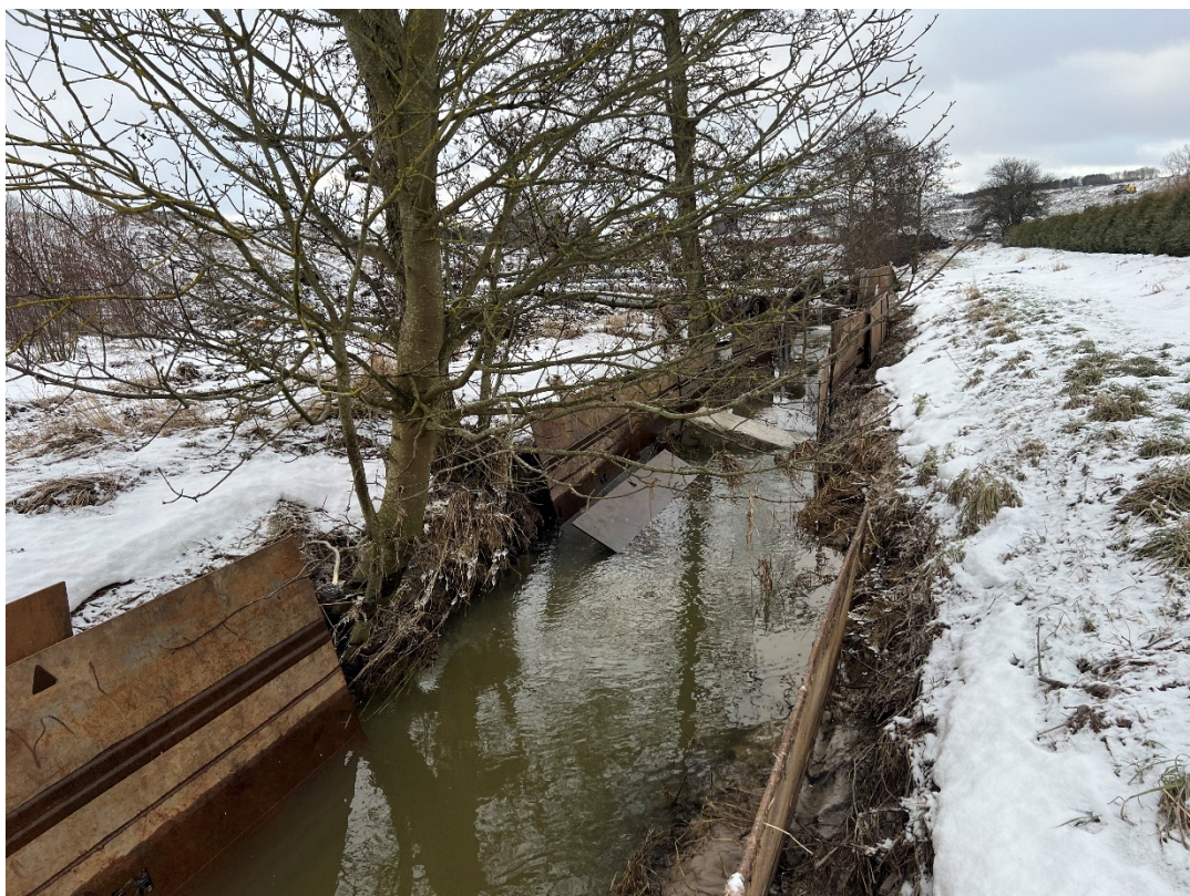
Figur 2 Foto optaget ca. 150 m nedstrøms igangværende overpumpning
