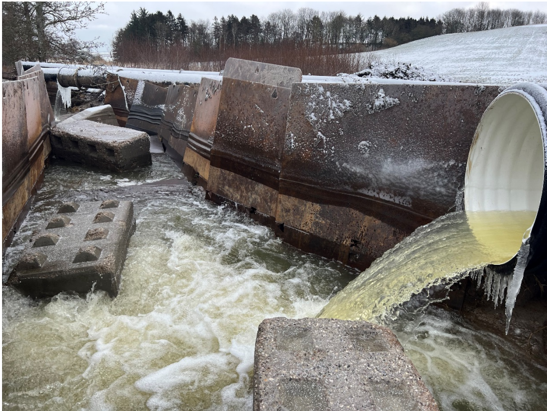
Figur 1 fotos af overpumpningen til Alling Å ved udløb gartneriet i Ølst
