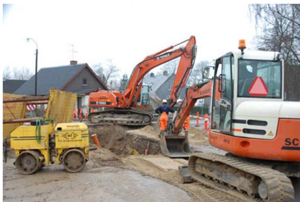
Kloakarbejder i Råby.
