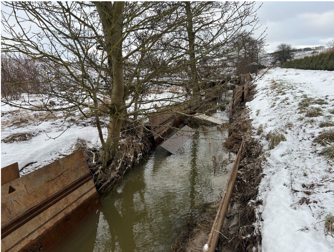
Figur 2 Foto optaget ca. 150 m nedstrøms igangværende overpumpning
